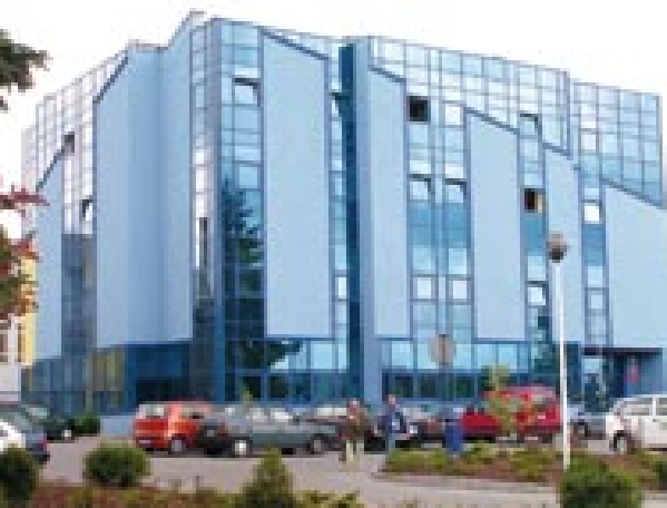
Fasada Sądu Rejonowego w Radomsku
