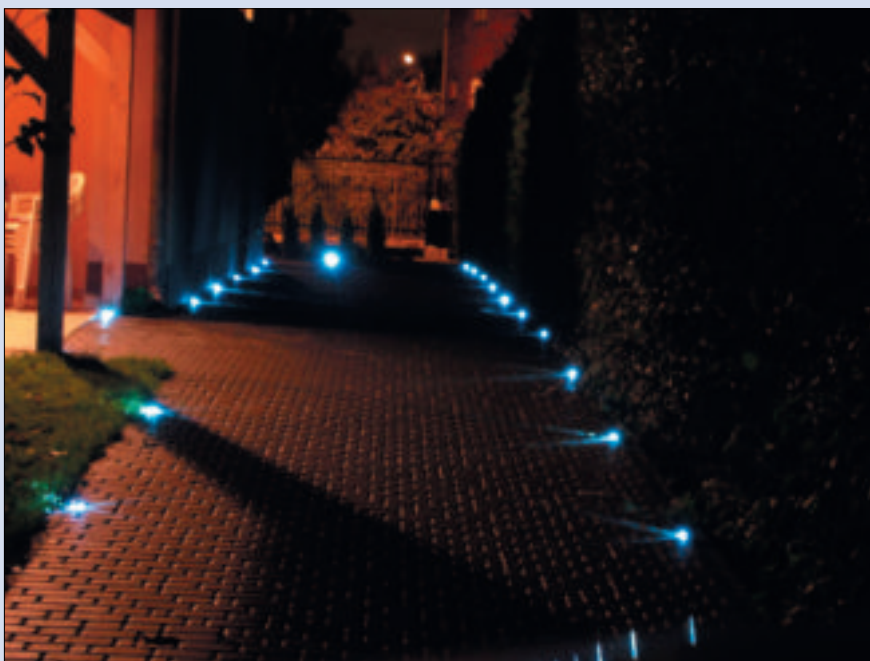
8 Oprawy wkopane w ziemię tworzą oryginalny system oświetleniowy (Limex)
