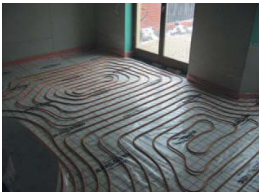
1 Rury miedziane miękkie można dowolnie wyginać i dzięki temu możemy je stosować w ogrzewaniu podłogowym (fot. Wieland)
