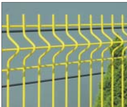
3 Ogrodzenie metalowe malujemy przy umiarkowanie ciepłej aurze, najlepiej w temperaturze 15-20°C. Rezygnujemy z prac, gdy słupek ręki spada poniżej 10°C (fol. Firma WIŚNIEWSKI)
