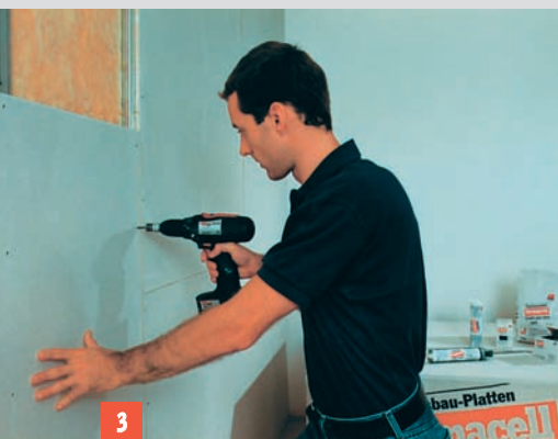
Przykręcanie płyt do pionowych profili CW co ok. 25 cm
