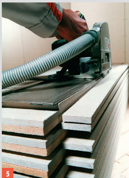
5 Usuwanie zakładki z płyt skrajnych
