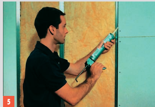
Nanoszenie kleju następuje przed ułożeniem kolejnej płyty
