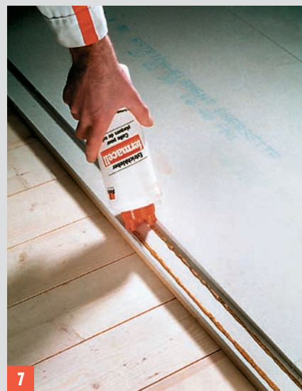
7 Nakładanie kleju
