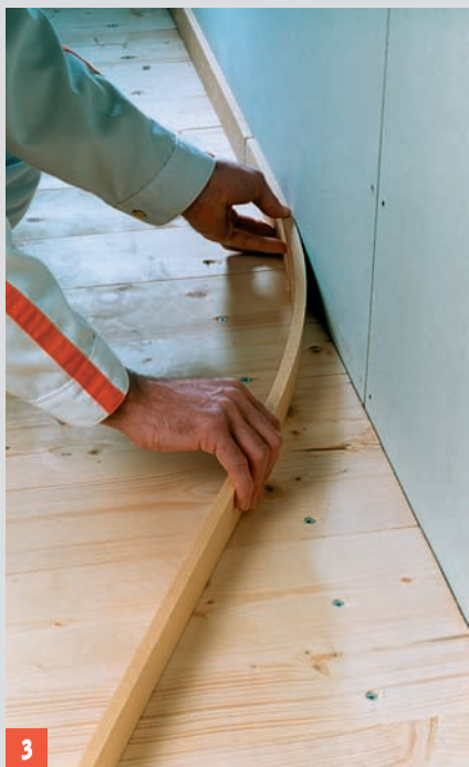
3 Układanie taśmy dylatacyjnej przy ścianie
