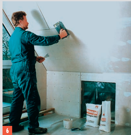
Alternatywny sposób spoinowania z użyciem masy szpachlowej
