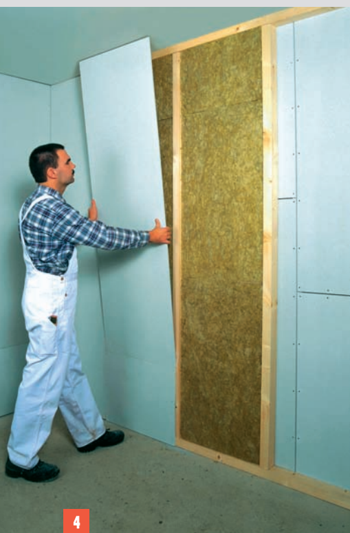
Montaż ścian o konstrukcji drewnianej
