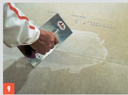
9 Maskowanie połączeń masą szpachlową
