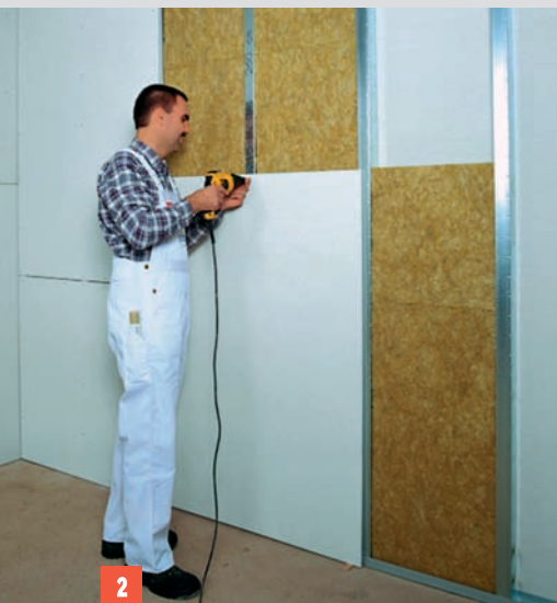
Montaż ścian o szkielecie stalowym
